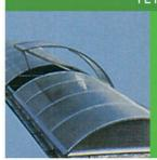
Voûtes d'éclairement zénithal à structure métallique autoportante et plaques de remplissage en polyméthacrylate ou polycartbonate.
