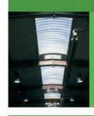
Éléments de couverture translucides, nervurés, cintrés, autoportants.
